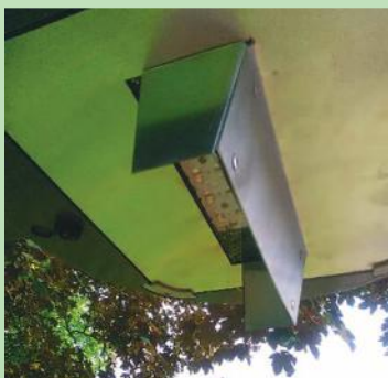
Lampadaire comportant plusieurs modules LED de température de couleurs différentes et munis de coupe-flux. Source : Yohann Tison - Ville de Lille.
